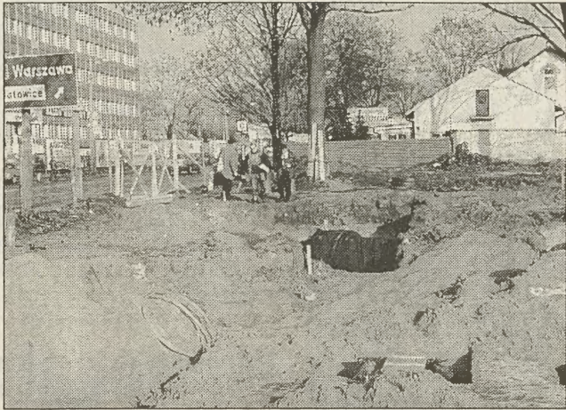
Przy Al. 29 Listopada rozpoczęto już budowę
