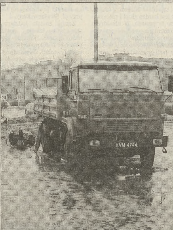
Kierowcy jadący al. Powstania Warszawskiego w kierunku Mogenskiej powinni uważać na stojące na poboczu samochody robotników, instalujących podświetlane słupy reklamowe
