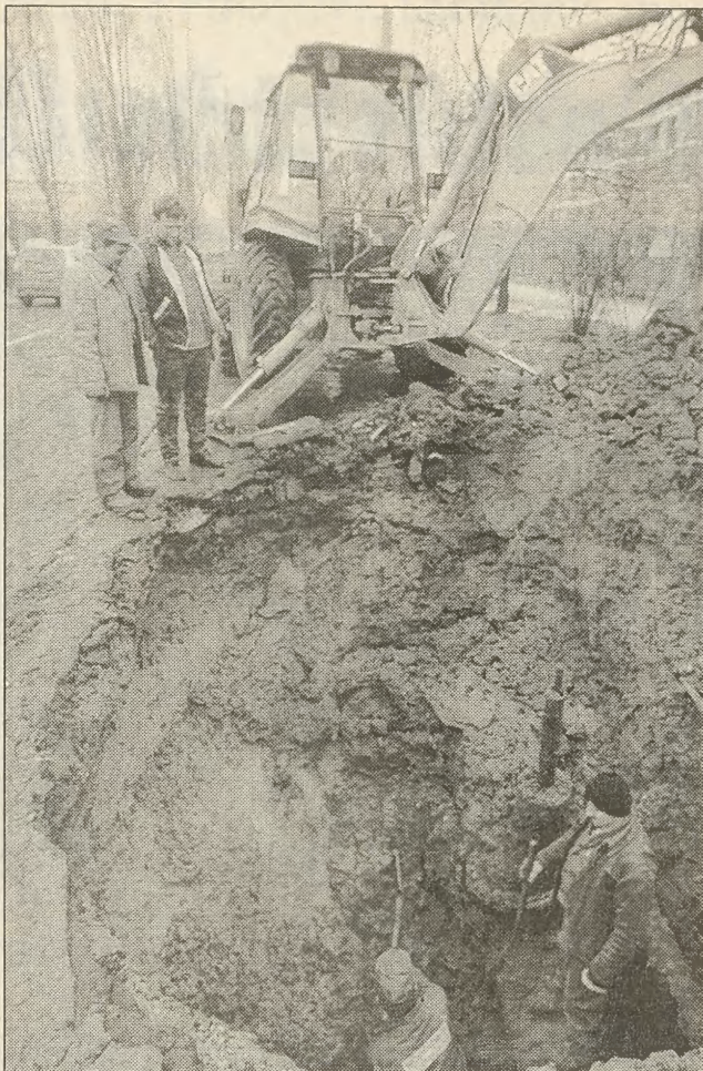
Os. Albertyńskie. Kolejna fala mrozów spowodowała, że wczoraj ekipy naprawcze z Przedsiębiorstwa Wodociągów i Kanalizacji miały pełne ręce roboty
