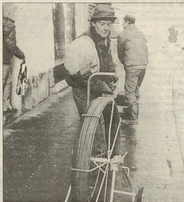
Na ul. Brackiej trochę utrudnień, ale za to mieszkańcy będą mieć lepiej — ciągną nowe kable telefoniczne Fot. Jadwiga RUBIS
