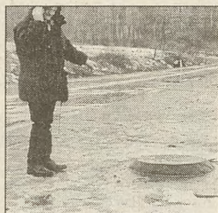
W 1999 roku 1,4 mld zł „zeżarła” dziwna inwestycja — 124 metry biegnące tzw. kanalizacji opadowej przy drodze krajowej nr 952...
