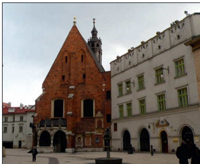
21 marca, czwartek, godz. 18:00 - św. Barbary (NMP na Zatybrzu)
