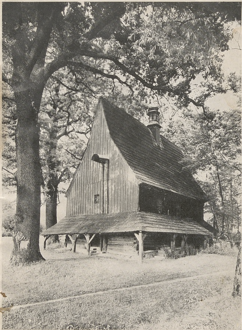
Kościółek św. Leonarda w Lipnicy Murowanej, w XIV—XV.
