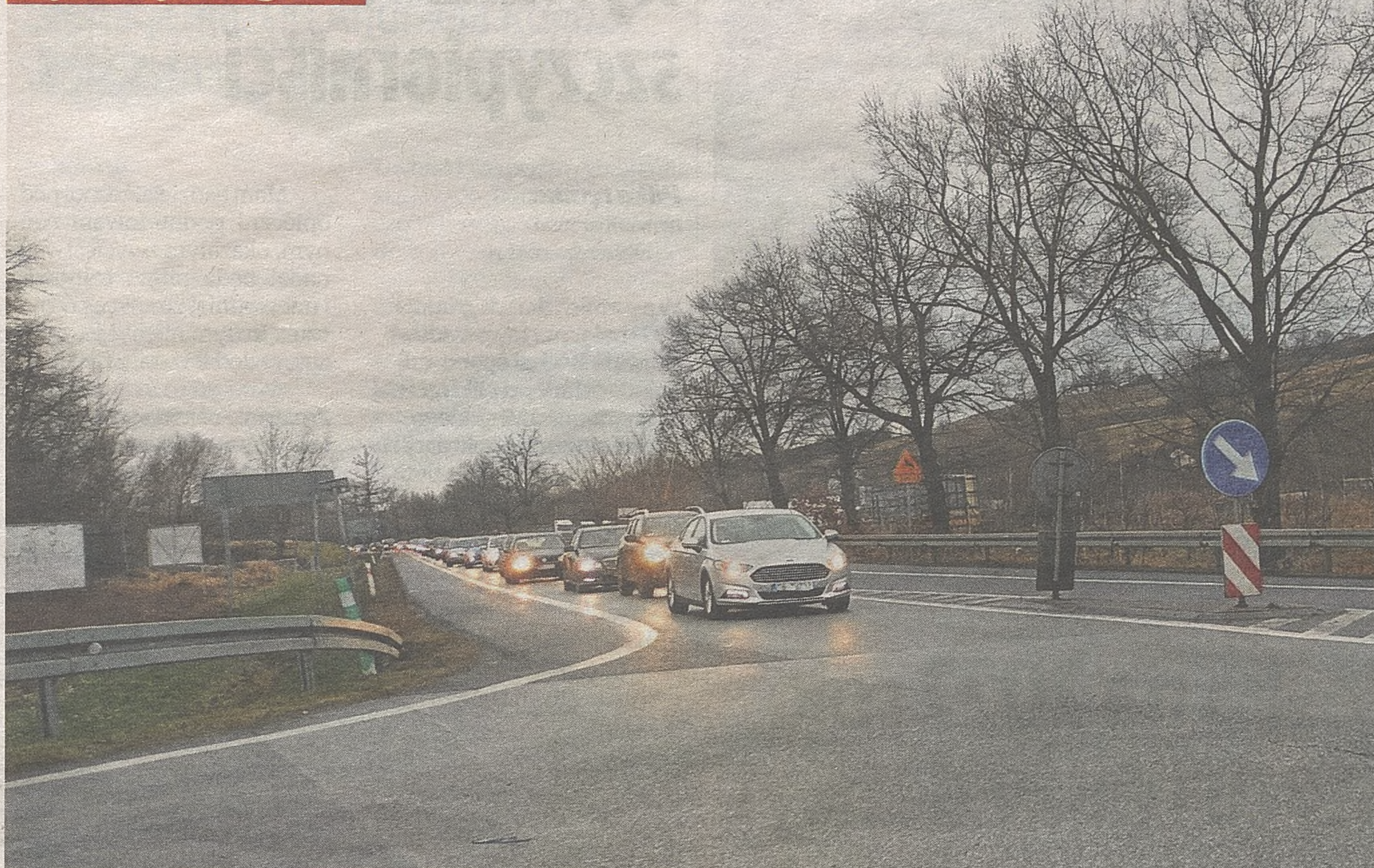
Planowana niegdyś obwodnica Łapczycy nie powstała, czego negatywne efekty widać coraz wyraźniej (korek w Wigilię 2021)
