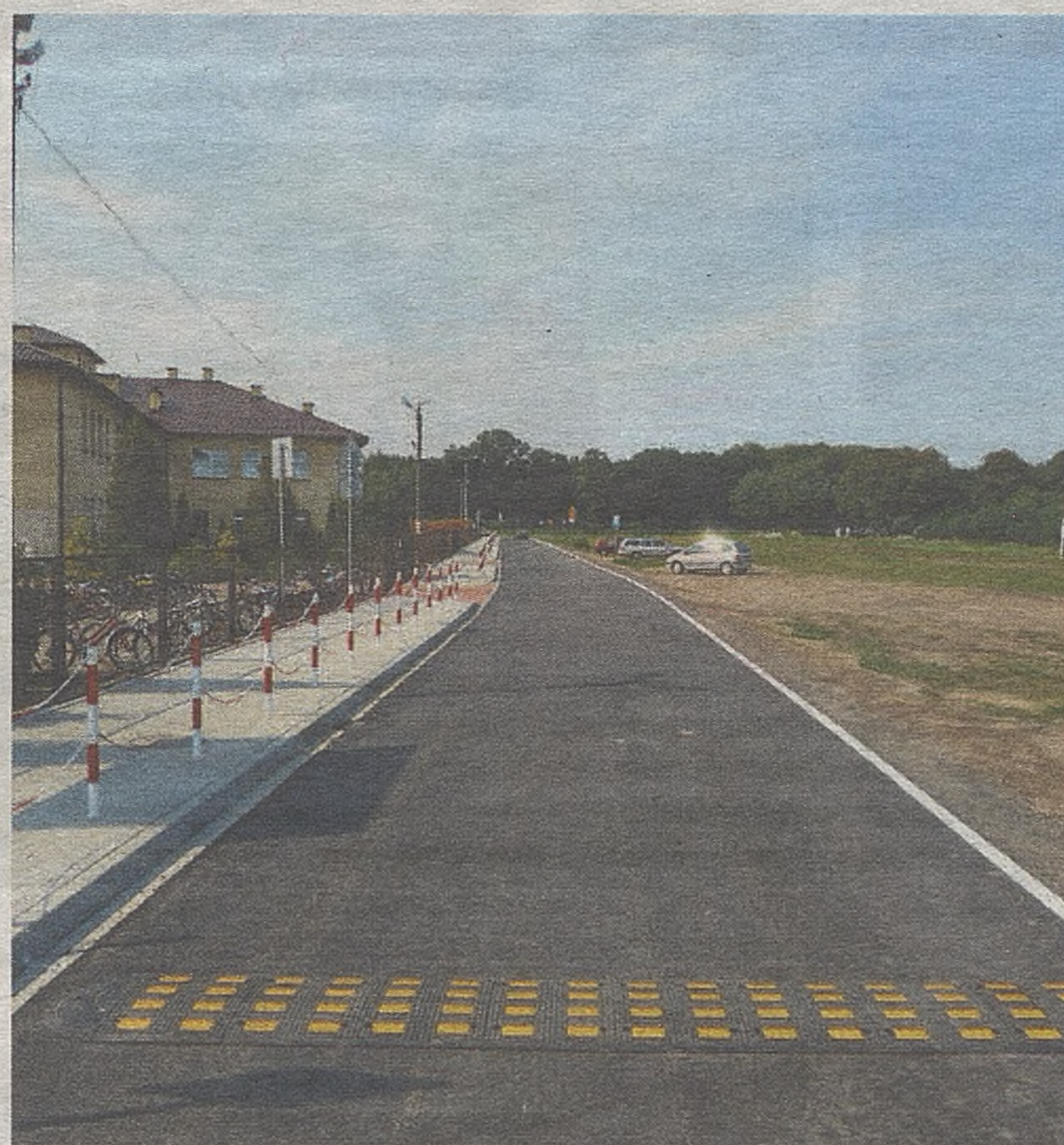
Jedna z dróg wyremontowana z programu rozwoju gminnej i powiatowej infrastruktury
