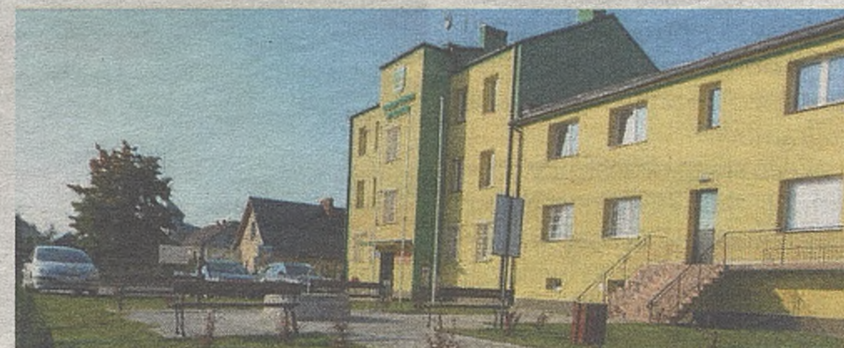
Budynek Urzędu Gminy po przeprowadzonej termomodernizacji
