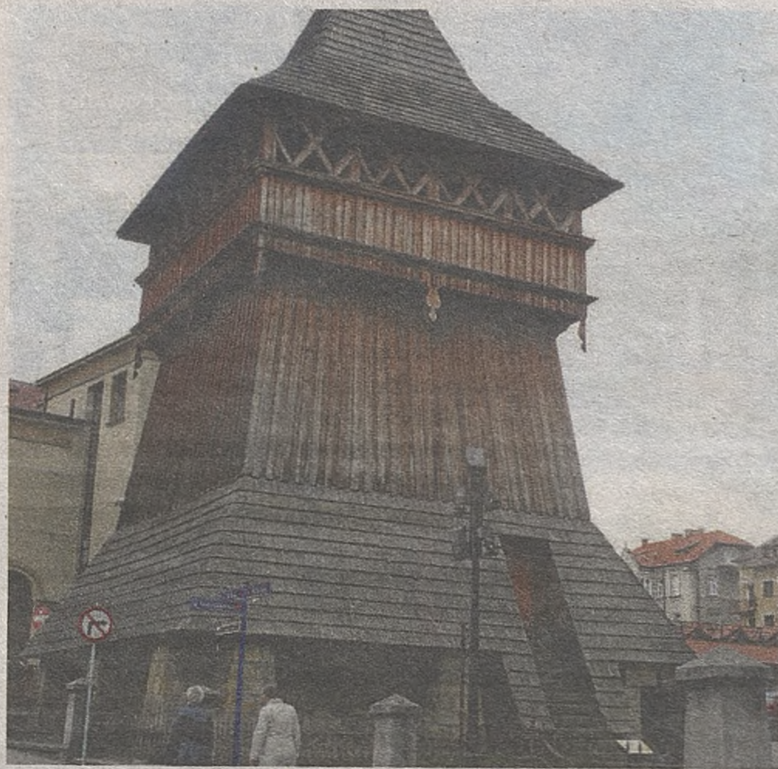
► Dzwonnica obok Bazyliki nie ma odpowiedniego zabezpieczenia
