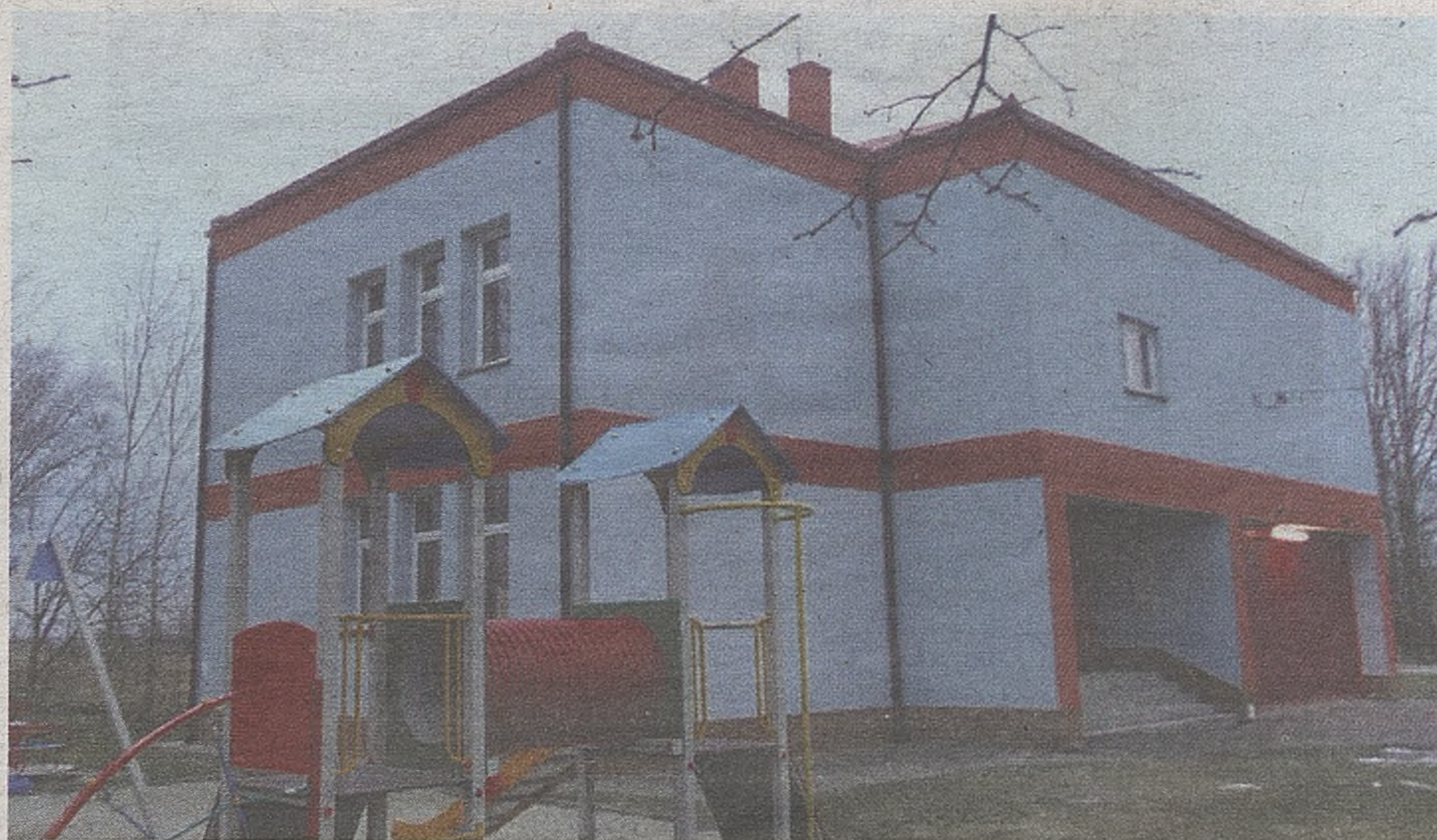
Budynek domu ludowego w Woli Drwińskiej po termomodernizacji
