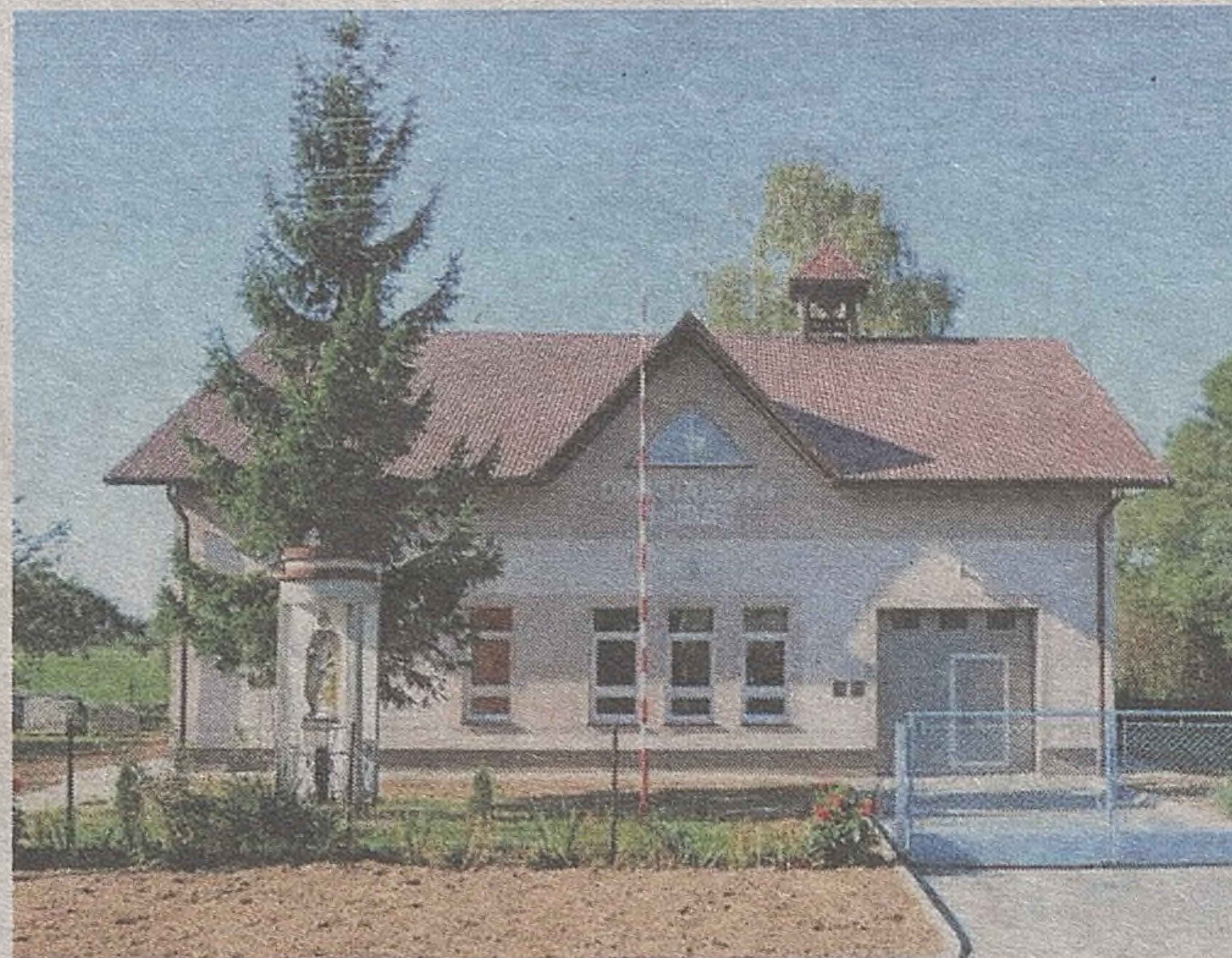
Termomodernizacja remizy OSP w Siedlcu
