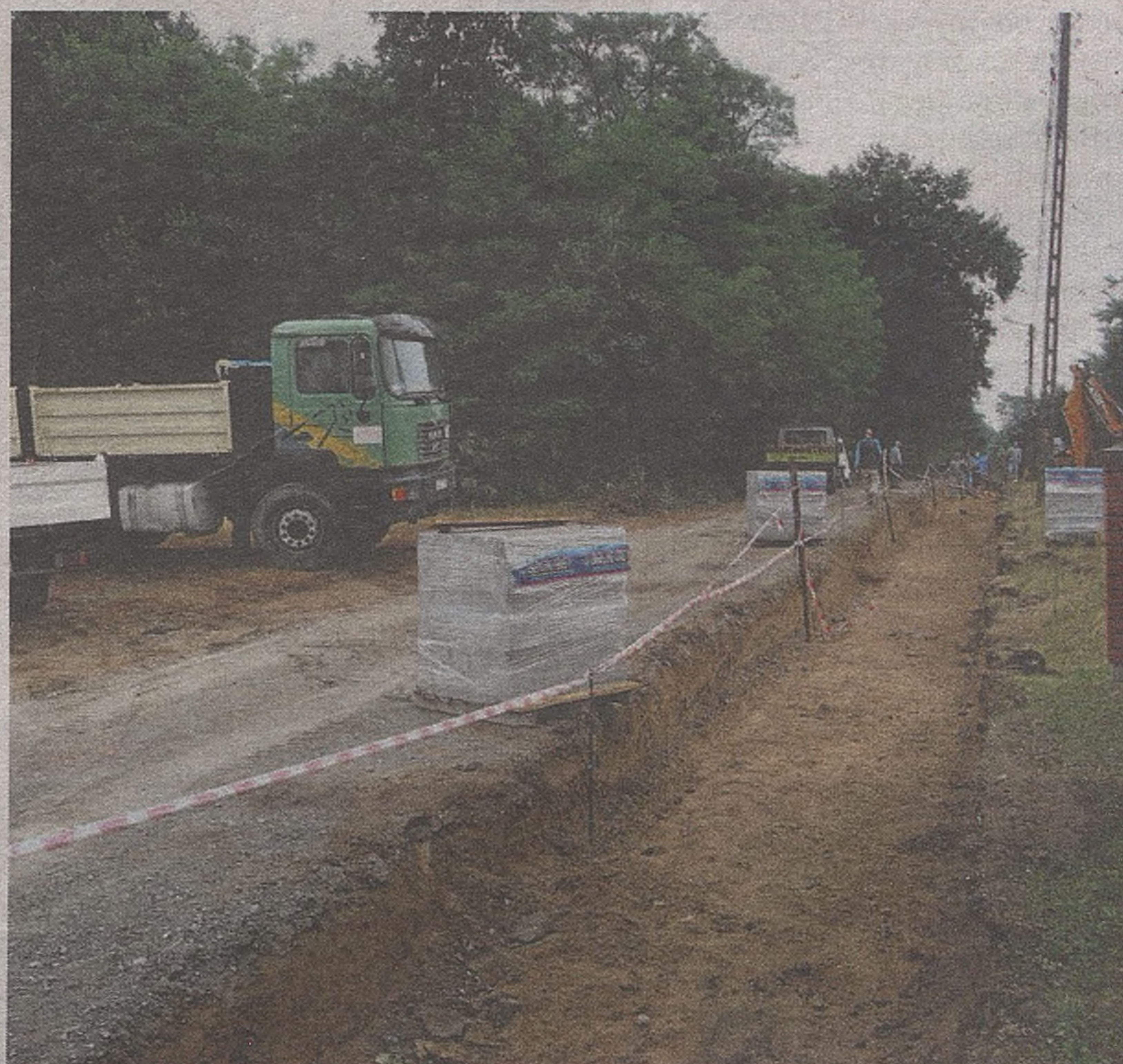
Remont ulicy Brata Alberta Chmielowskiego
