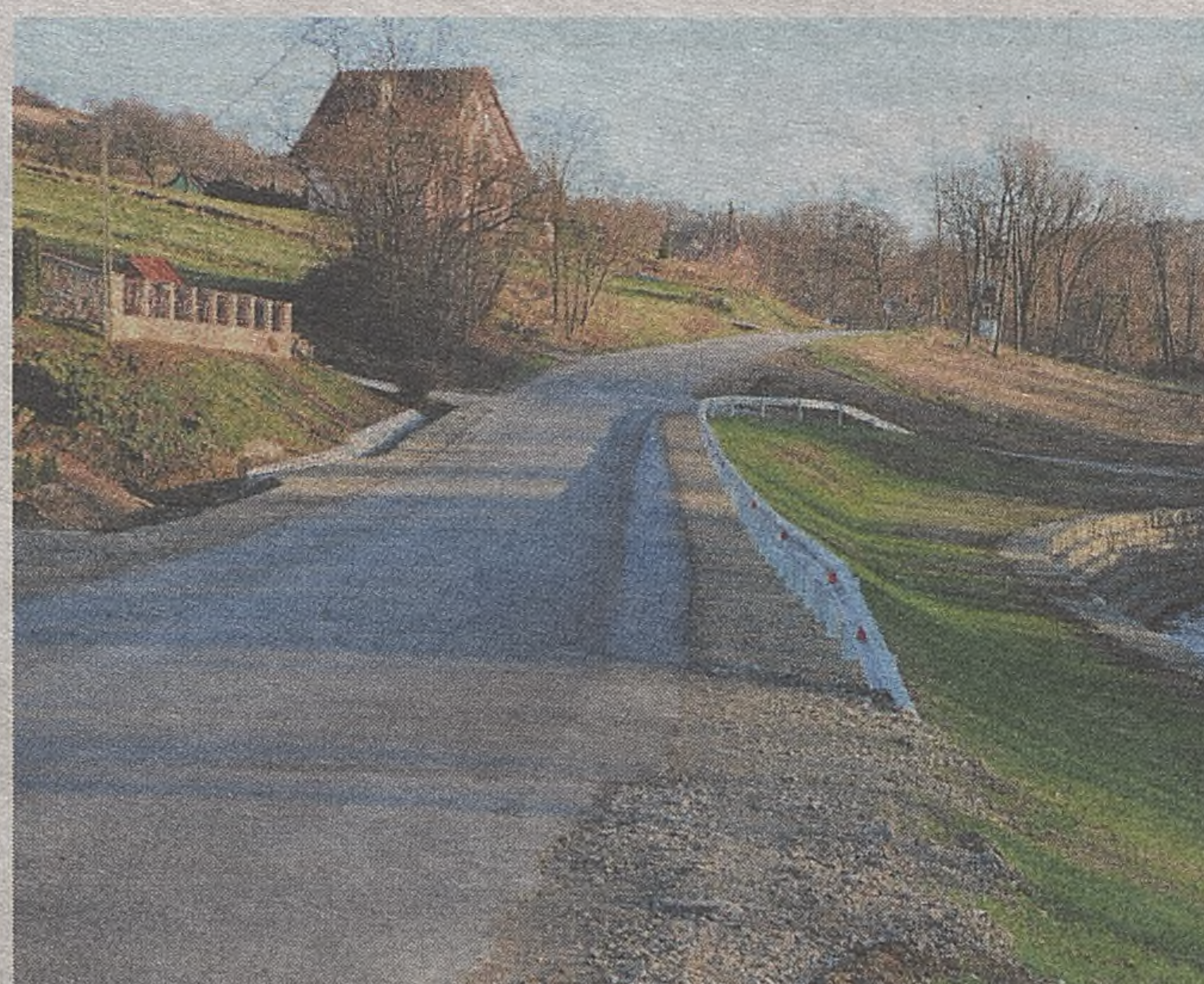
Rajbrot – odbudowany odcinek byłego osuwiska
