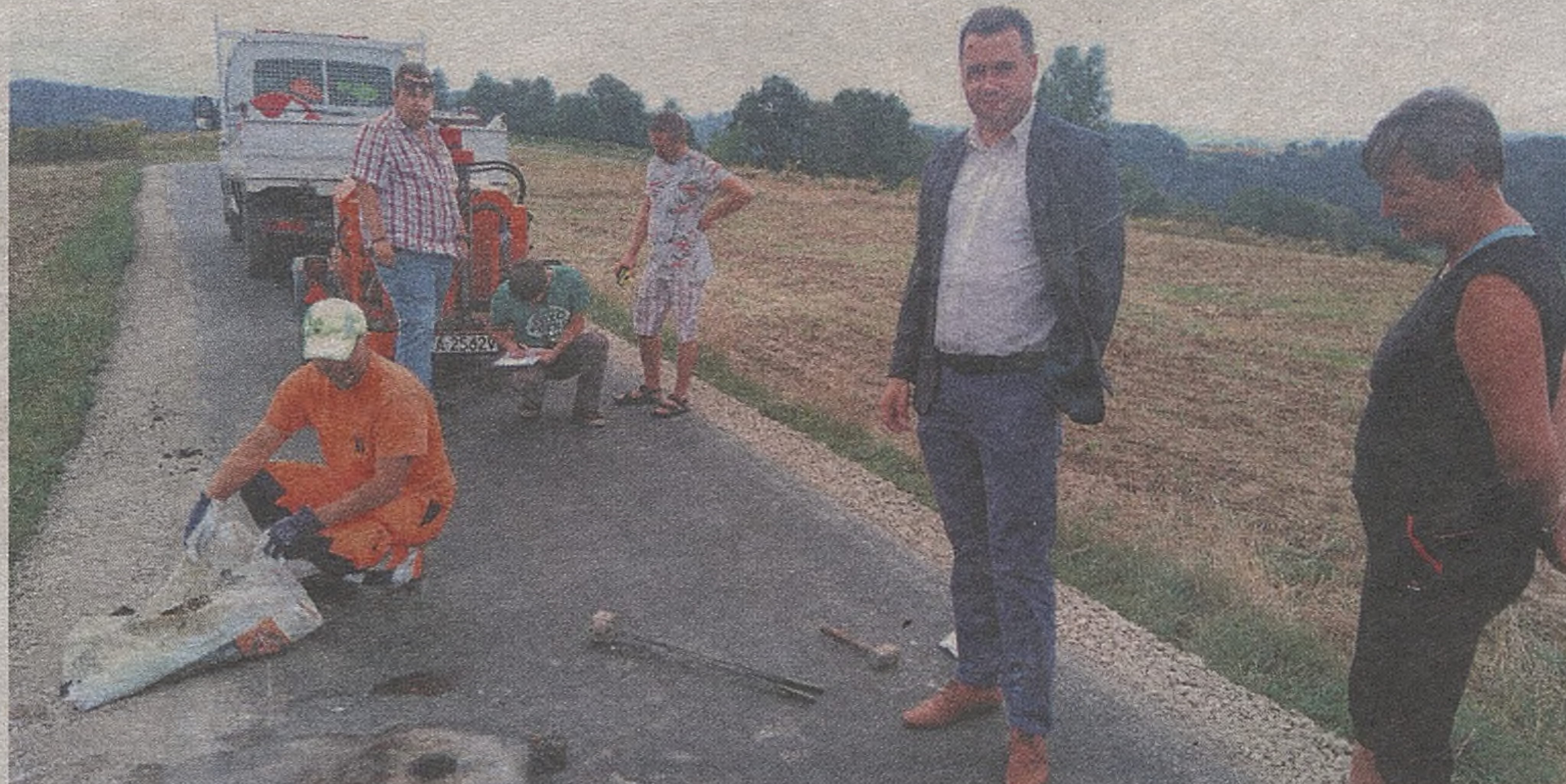
W gminie Zakliczyn w ub. roku wprowadzono wykonywanie obowiązkowych odwiertów przed ostatecznym odbiorem technicznym dróg. Sprawdza się grubość i skład asfaltu, zabezpieczając w ten sposób interes gminy czyli mieszkańców
