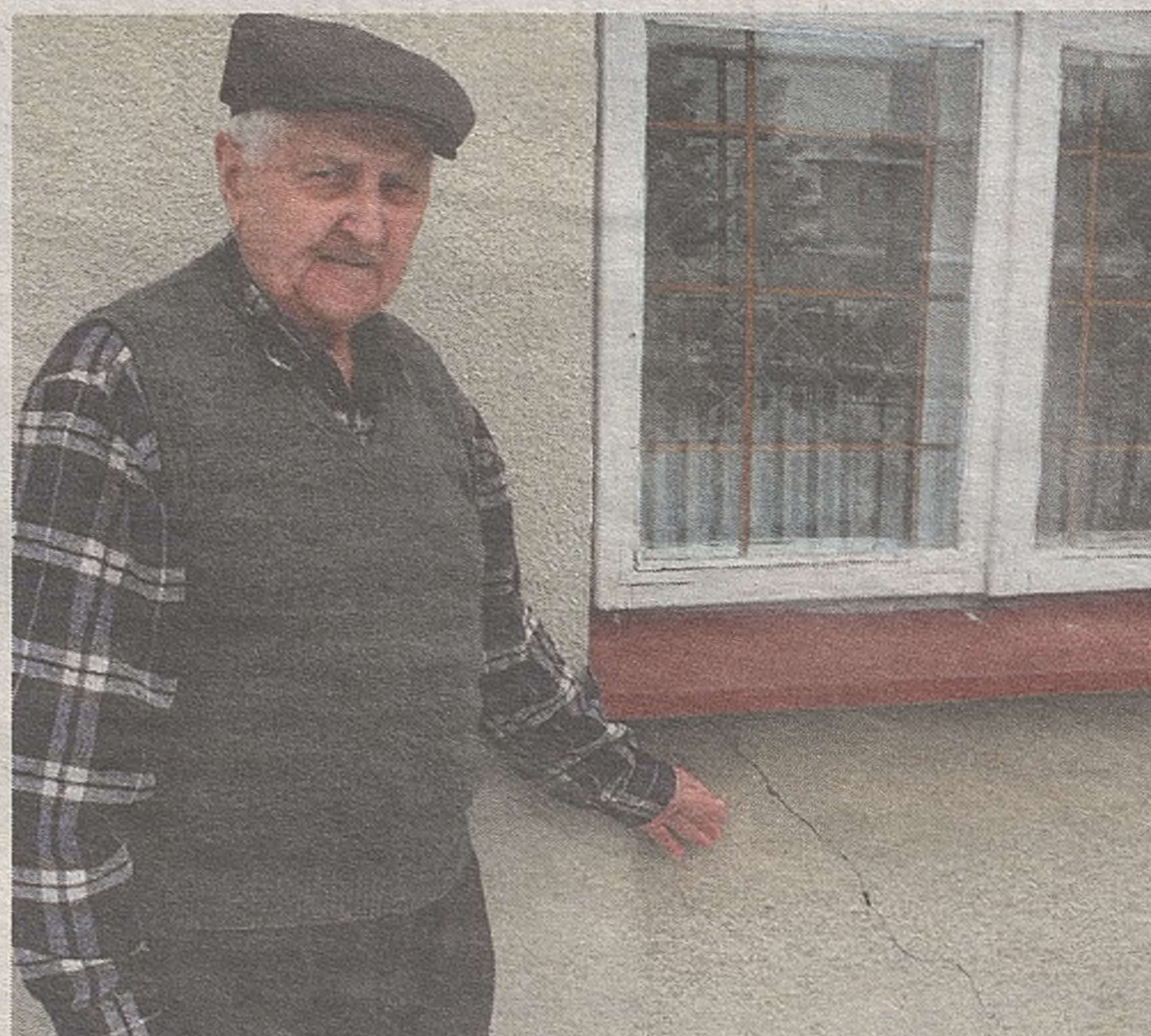
► Stefan Dyba skarży się na pęknięcia w ścianie zewnętrznej domu. - Z miesiąca na miesiąc rysa jest coraz większa - zaznacza
