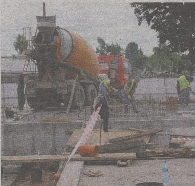
W Borzęcinie zaczęły się prace przy budowie Regionalnego Centrum
