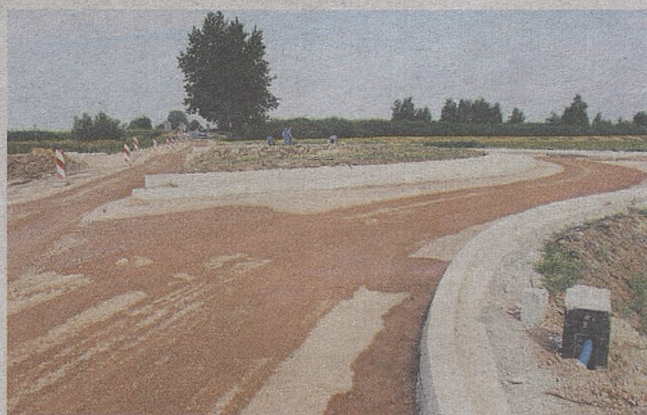
Rondo na budowanej obwodnicy Szczurowej
