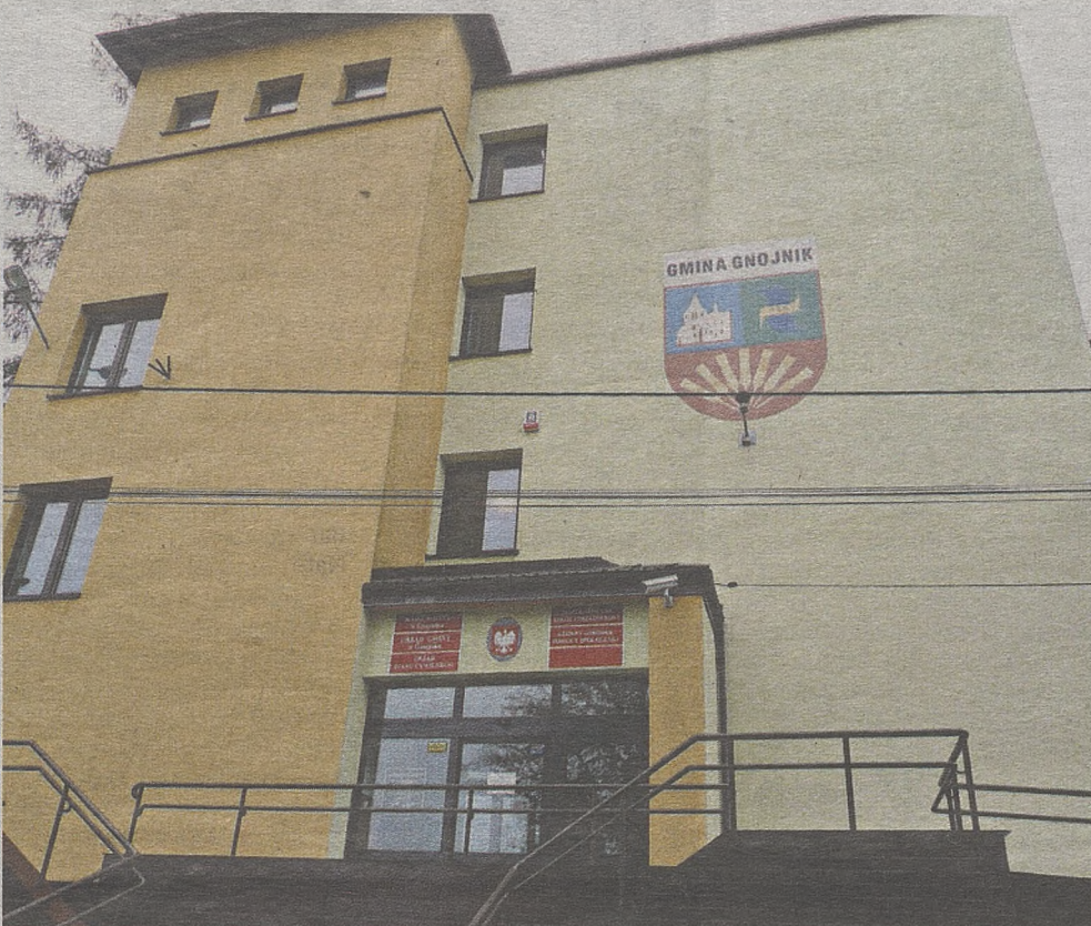
Maszty nadawcze zostaną ustawione na budynkach należących do Urzędu Gminy w Gnojniku
