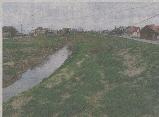
W Borzęcinie prace prowadzone są na Uszwicy i na innych potokach
