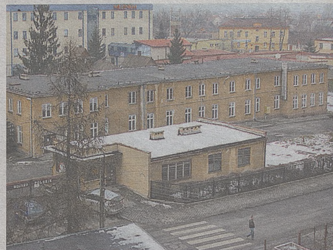
Budynek po Wojskowej Komendzie Uzupełnień przy ulicy Świętego Leonarda. Na pierwszym planie dawna wojskowa wartownia
