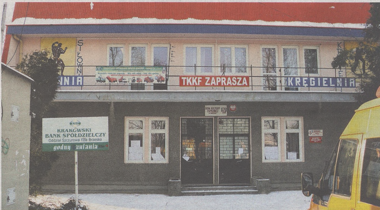
Remont budynku kręgielni zostanie ukończony pod koniec kwietnia. Na zakończenie prac przewidziano modernizację torów oraz sprzętu
