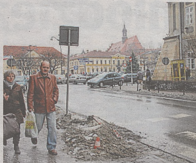
Tak wygląda w czasie odwilży bardzo ruchliwy odcinek chodnika i przejście dla pieszych w centrum Bochni
