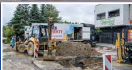
8 mln zł na remont ul. Słonecznej - s.5
