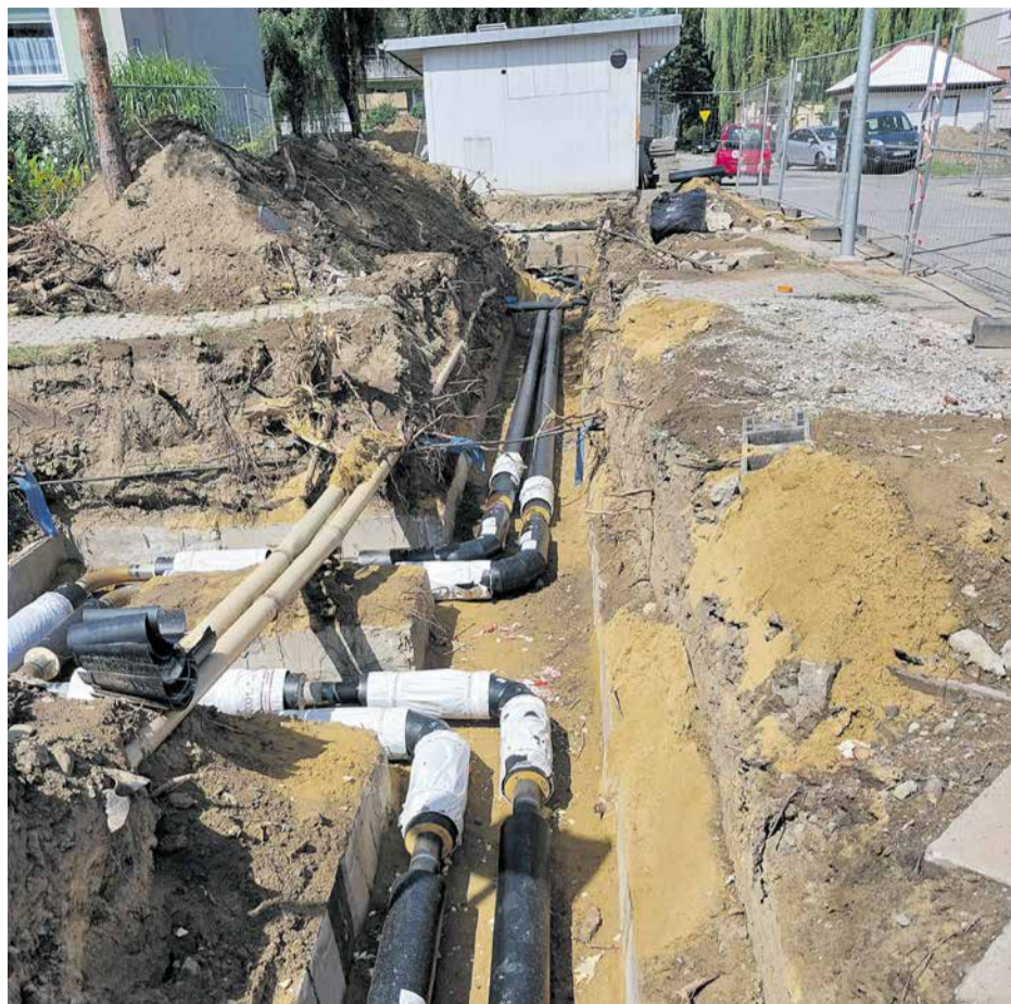
Teraz średnica przewodów ciepłowniczych to DN 300. Zastosowano najnowszą technologię o niskich współczynnikach przenikania ciepła. Spory odcinek starej magistrali, wychodzący z ciepłowni w kierunku „blaszankowskich” bloków, był napowietrzny. Teraz został „wkopany” w ziemię, dzięki czemu na inwestycji zyskała też estetyka.
