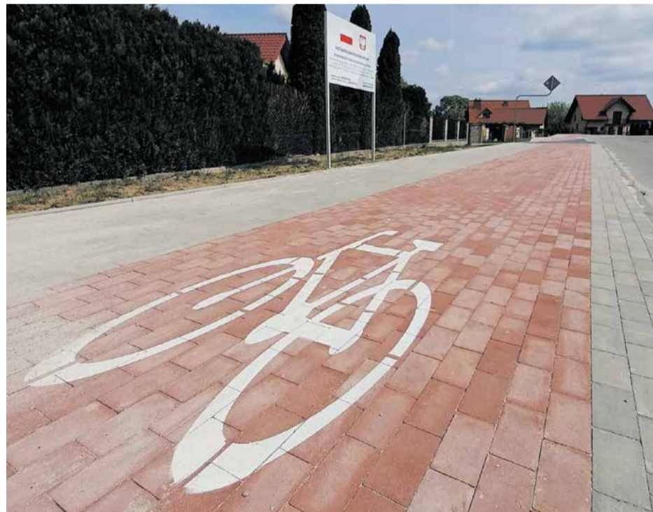
Budowa chodnika i ścieżki rowerowej przy ulicy Sikorskiego znacznie wpłynęła na poprawę bezpieczeństwa w ruchu drogowym i pieszym.
