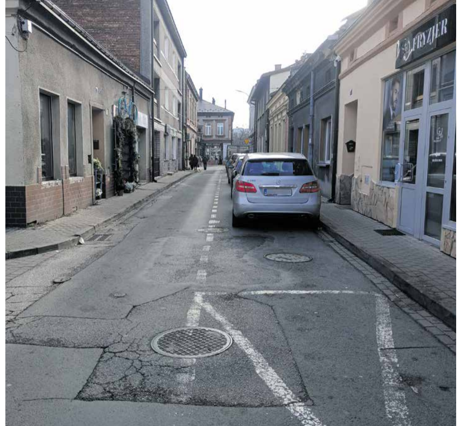
Remont ulicy Zielonej będzie wspianym uzupełnieniem kompleksowej modernizacji ulic Starego Miasta. (fot. Konrad Wójcik)
