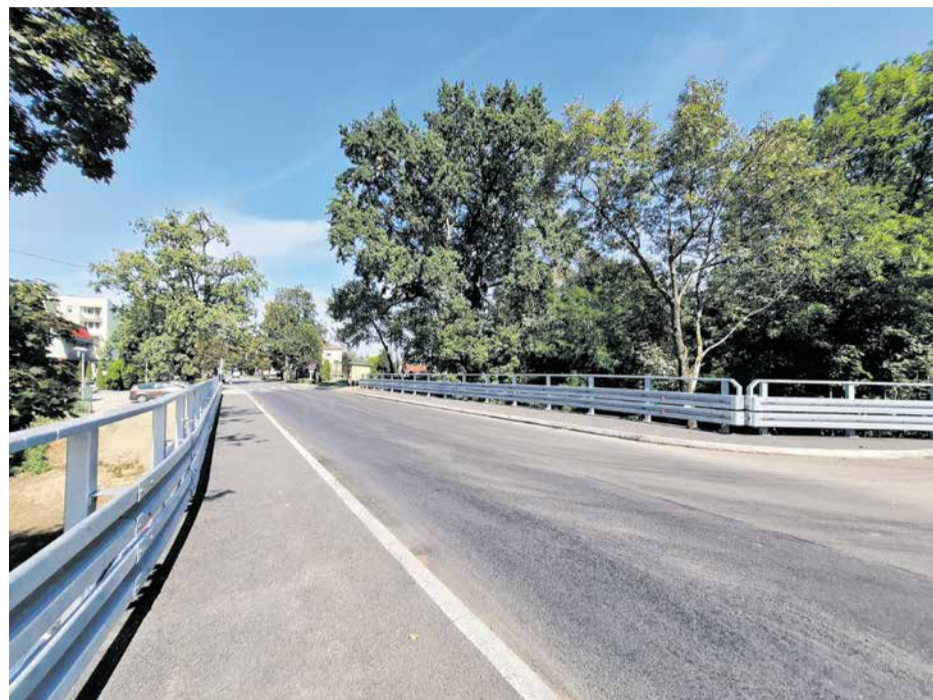
Remont mostu to niejako dopełnienie modernizacji całej ulicy Browarnej wykonanej w ramach projektu dofinansowanego z tzw. Polskiego Ładu.
