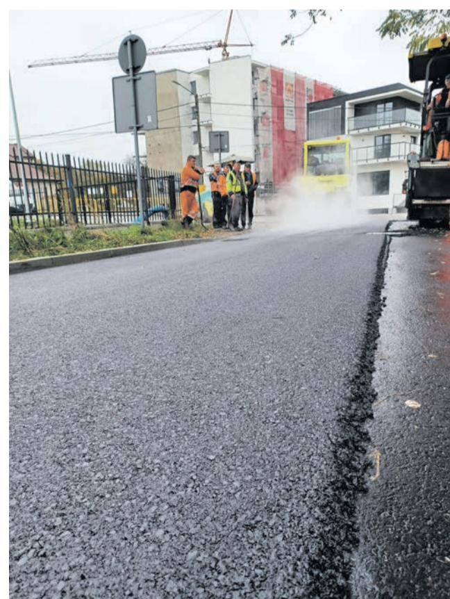
Pierwsza warstwa ścierlana na osiedlu Jagiełły
