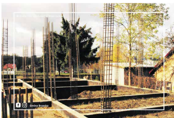
Tak wyglądał plac budowy w grudniu 2020 roku, po zakończeniu pierwszego etapu
