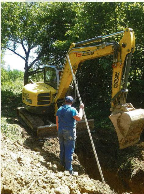
fot. Budowa magistrali wodociągowej
