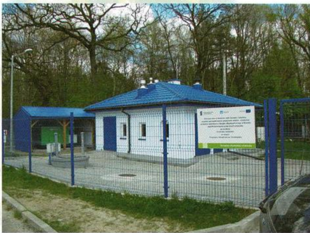
fot. Pompownia ścieków przy ul. Jasnej w Brzesku
