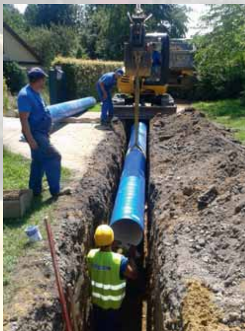
fot. Budowa magistraly wodociągowej
