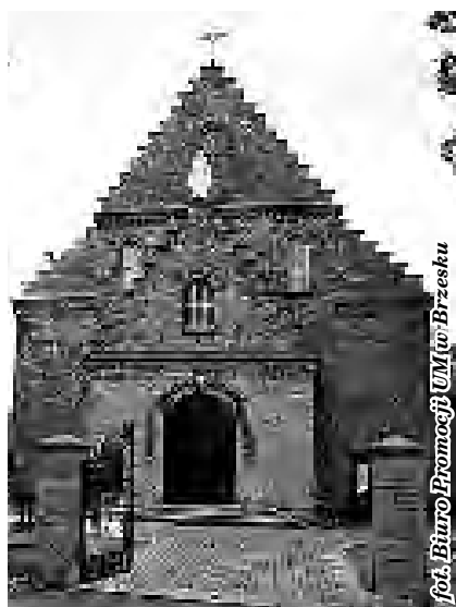
Fasada zachodnia kościoła
