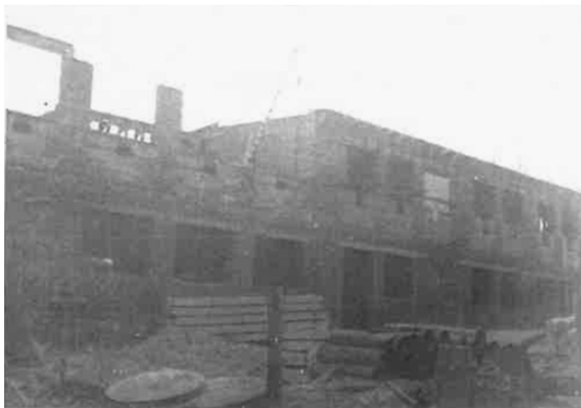
Budowa masarni w Sieprawiu
