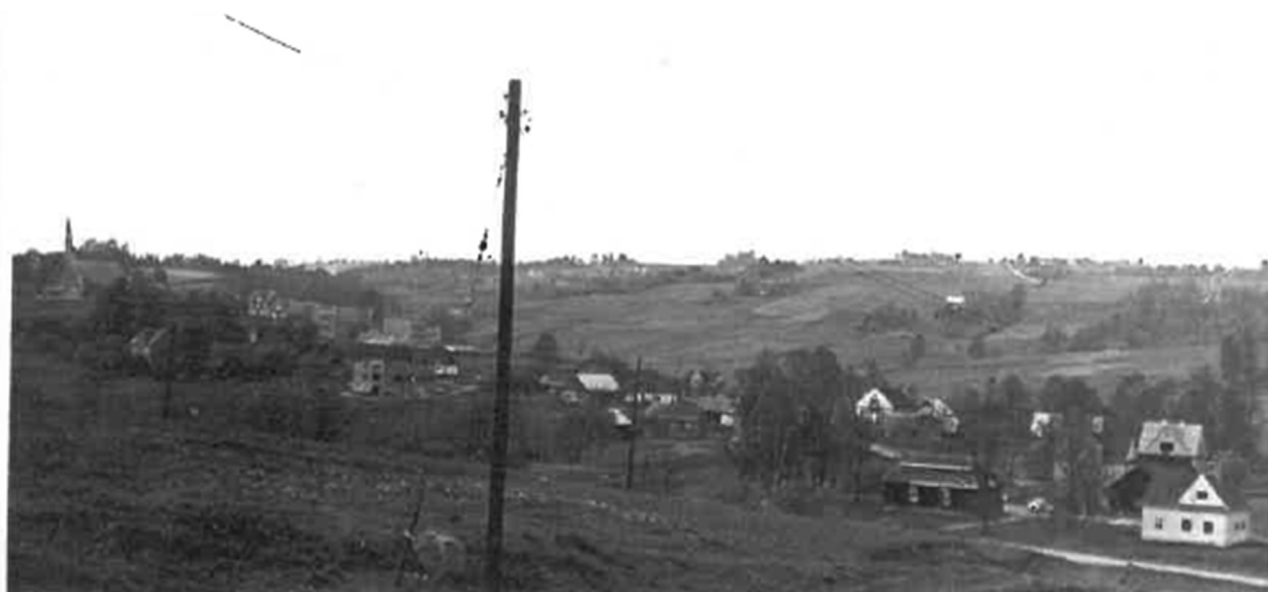
Panoramę dominuje słup energetyczny
