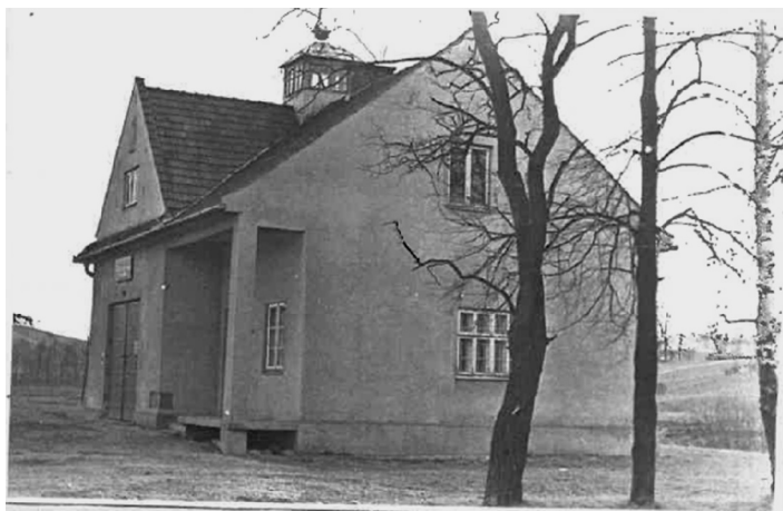
Budynek remizy OSP
