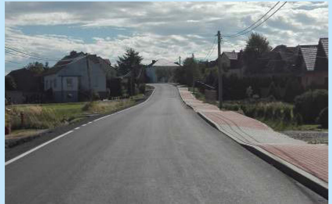
Wyremontowana droga - ul. Kamoinka w Zakliczynie str. 8
