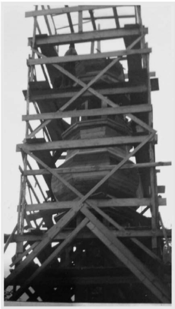
Deskowanie pod pokrycie blachą miedzianą na nowej sygnaturce starego kościoła - jesień 1999 roku
