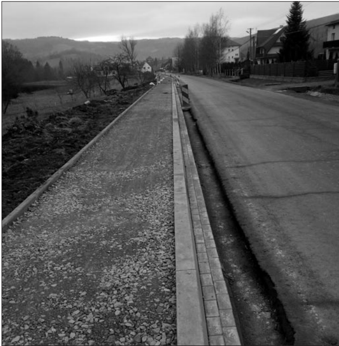
Budowa chodnika przy drodze powiatowej w Łętowie
