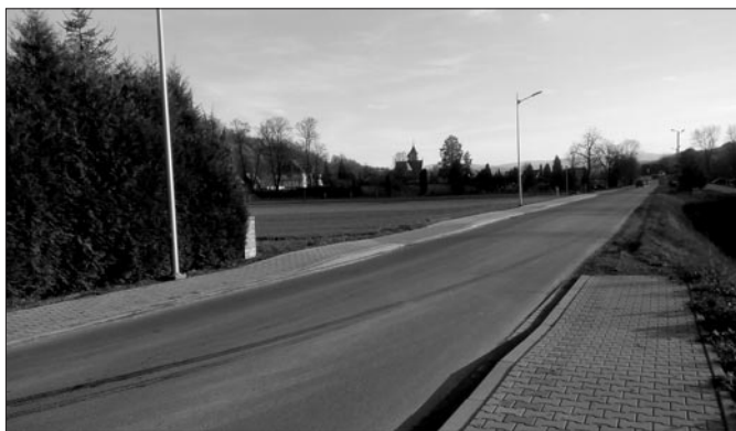
Chodnik przy drodze powiatowej w Kasince Małej
