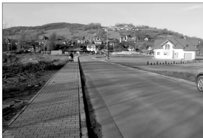
Chodnik przy drodze powiatowej w Kasince Małej
