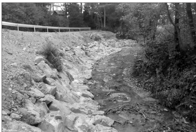
Zabezpieczenie drogi Kasina Wielka – Gruszowiec
