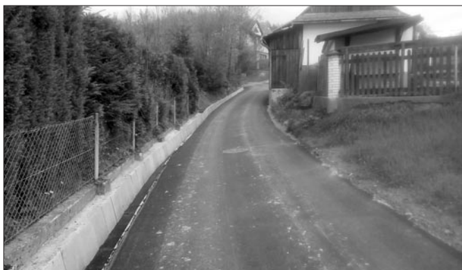
Droga na osiedlu Brzegi w Kasince Małej
