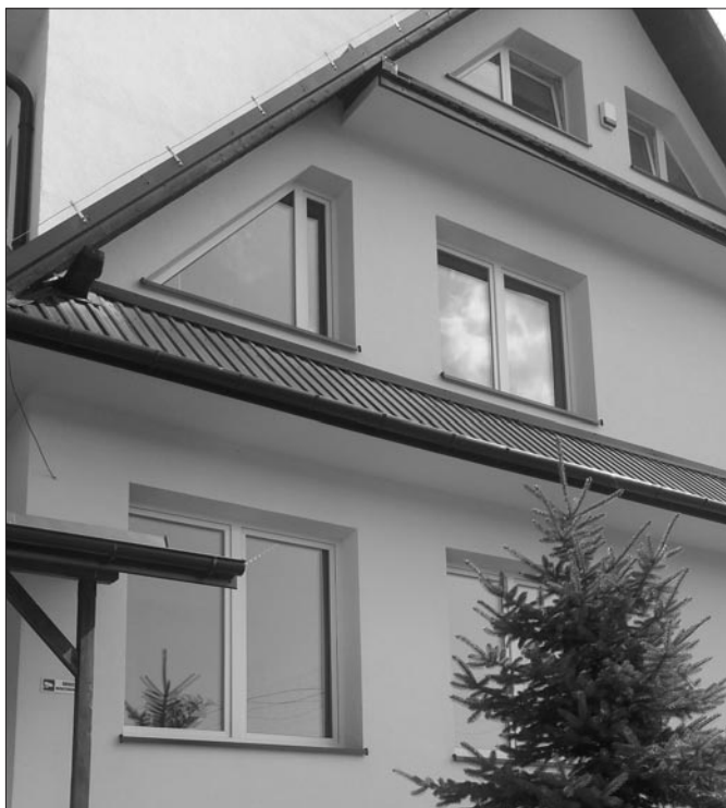
Termomodernizacja SP nr 3 w Kasince Małej
