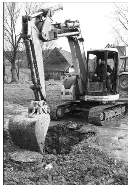
Budowa kanalizacji sanitarnej w Mszanie Górnej
