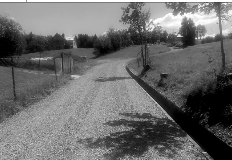
Droga o nawierzchni tłuczniowej z odwodnieniem na osiedlu Waligóry w Olszówce
