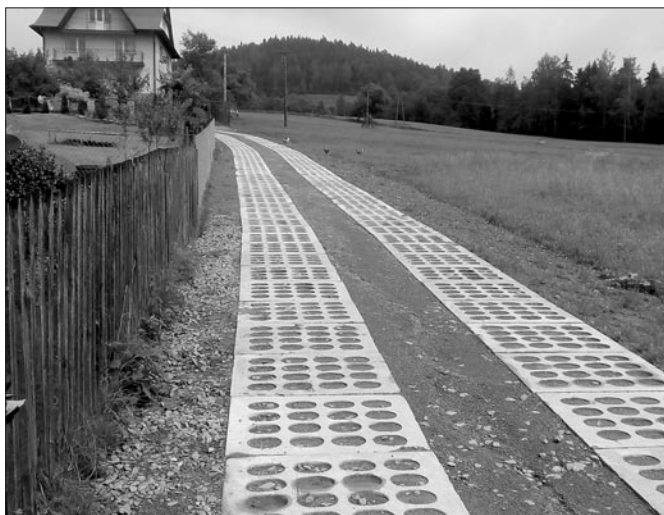
Droga na osiedlu Snozy w Łętowie
