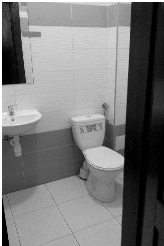
Nowe sanitariaty w budynku „A” ZPO w Kasinie Wielkiej
