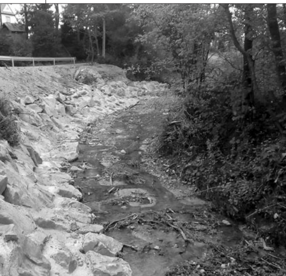
Remont drogi gminnej Kasina Wielka – Gruszowiec
