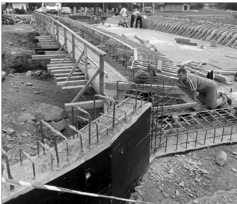
Budowa mostu do osiedla Pyrze, Brzegi w Kasince Małej
