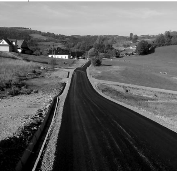
Budowa drogi Mysze – Drewniakówka w Łętowie
