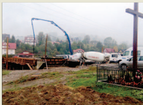
Pełna mobilizacja – inwestycje komunalne na terenie gminy STR. 10
