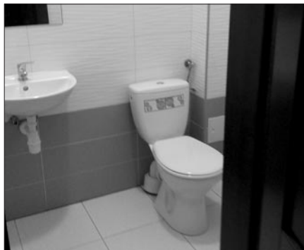
Remont sanitariatów w budynku A ZPO Kasina Wielka
