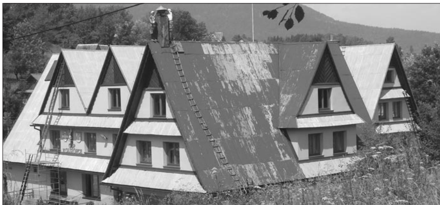
Remont dachu remizy OSP w Olszówce
