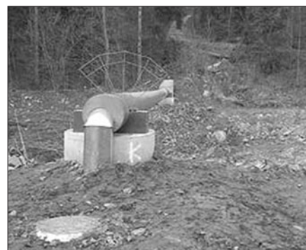
Kanalizacja w Kasince Małej
