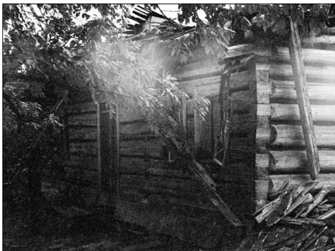
Zrujnowany dach domu Marii Ziemb, 1983 r.
