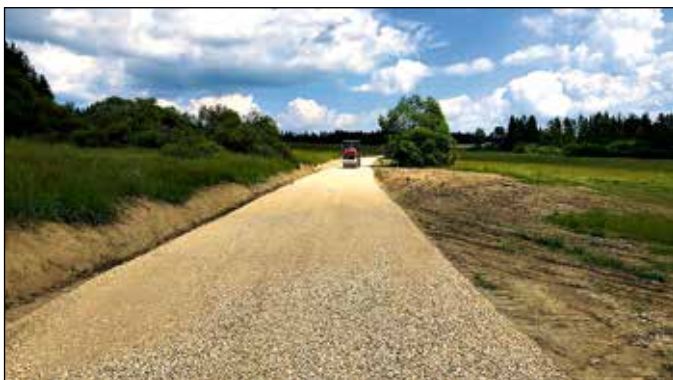
Budowa ścieżki rowerowej na drodze „Rabczyckiej”
