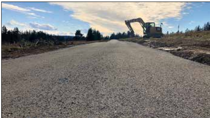
Remont drogi gminnej Lipnica Wielka – oczyszczalnia ścieków Kiczory
