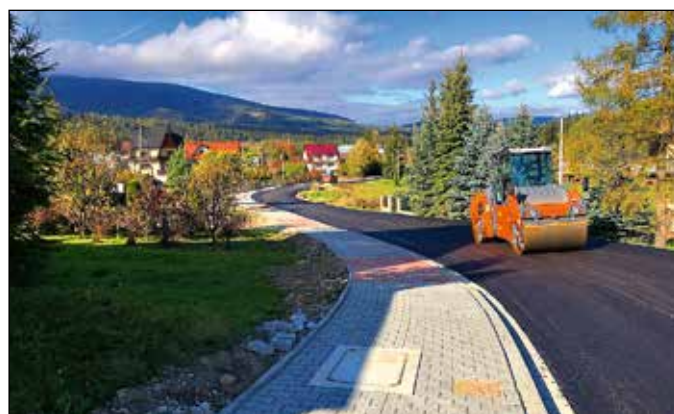
Przebudowa drogi gminnej publicznej w miejscowości Kiczory
