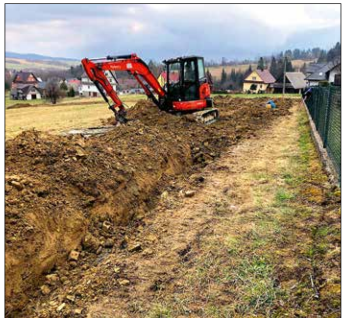
Wykonywanie sieci kanalizacyjnej na terenie sołectwa Skoczynki
