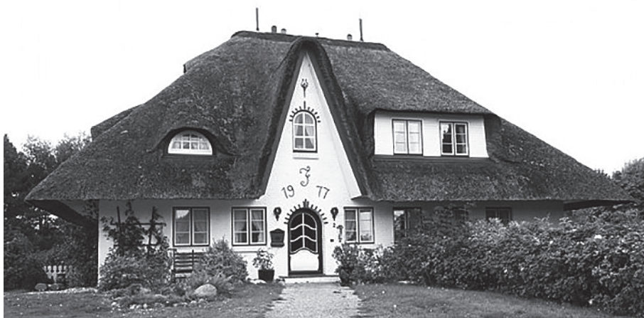
Dach z trzciny. Fot. Flickr
