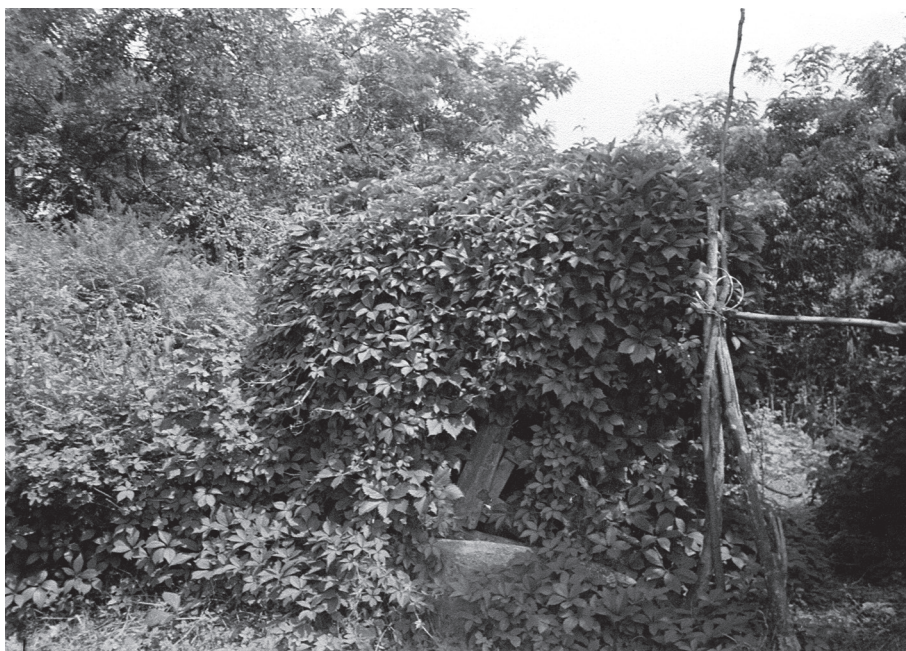
Studnia przed zawaleniem, 1996 rok
