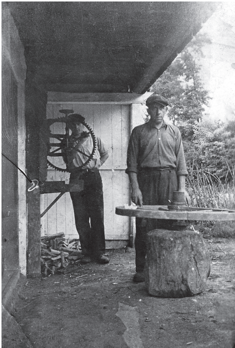
Kuźnia od strony ulicy. W podcieniu, na pierwszym planie mój dziadek – Józef Bujakowski zakuwający rachwę na drewniane koło, na drugim planie mój tato – Henryk Bujakowski stojący przy bormaszynie
