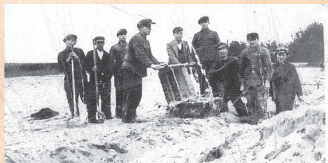
1942 r. Fundament pod barak na Dąbrowce (ze zbiorów A. Krawczyka)
