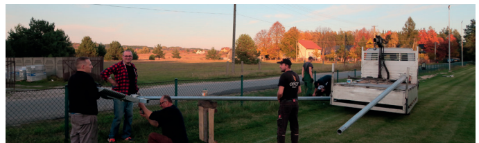
Montaż lamp na boisku sportowym w Chechle
