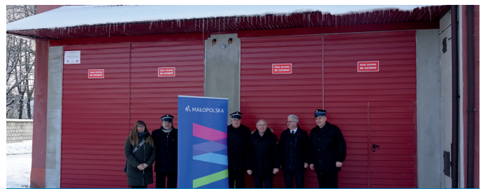
Uroczyste otwarcie świeżo wyremontowanych pomieszczeń garażowych w strażnicy OSP Bydlin
