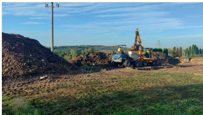
Budowa sali gimnastycznej przy ZSP w Kwaśniowie Dolnym
