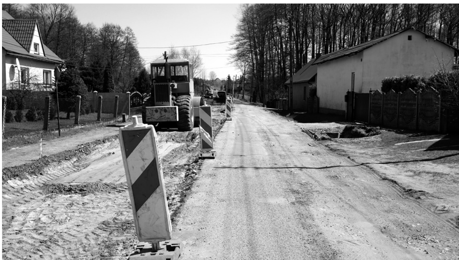
Przebudowa drogi powiatowej na odcinku w Ryczówku (fot. Rafał Jaworski)
