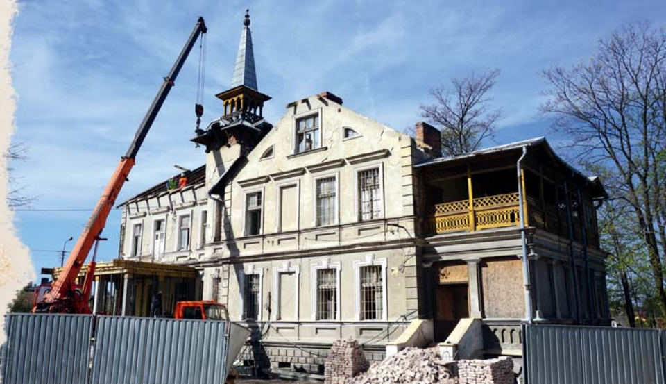
Prace adaptacyjne w dworku rozpoczęły się pod koniec 2018 roku.
