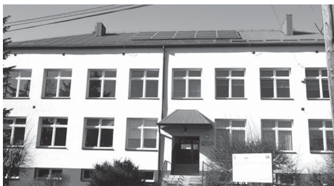
W 2017 r. projekt Gminy Klucze na termomodernizację trzech budynków oświatowych (w Bydlinie, Rodakach i Jaroszowcu) otrzymał dofinansowanie z RPOWM. Na zdjęciu: budynek Szkoły Podstawowej w Rodakach z zamontowanymi na dachu panelami fotowoltaicznymi.
