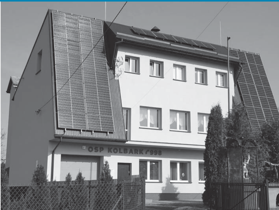
Panele fotowoltaiczne na dachu budynku wielofunkcyjnego w Kolbarku.
