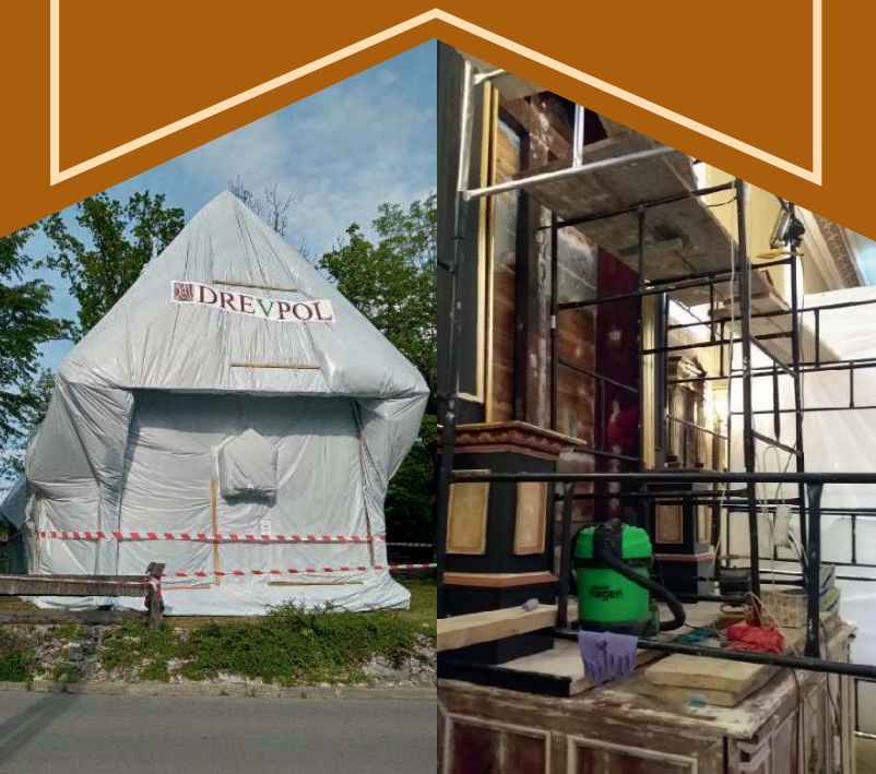
W trakcie prac konserwatorskich w Rodakach ( zdjęcie z lewej) i Chechle (z prawej).
