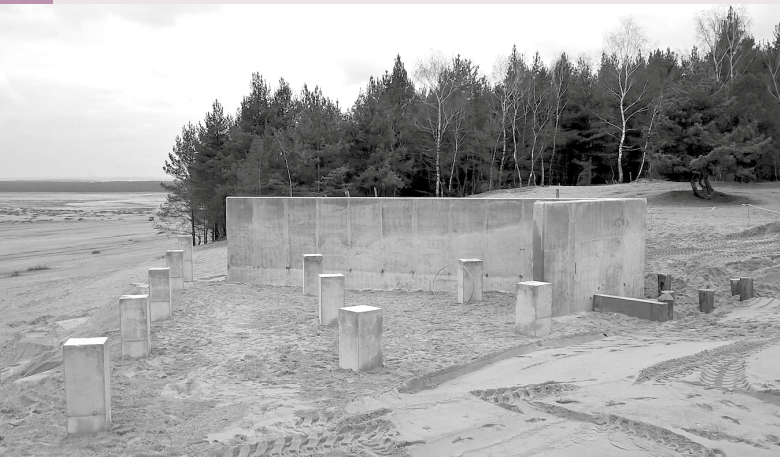
Budowa platformy widokowej na „Dąbrówce” w Chechle (projekt Rejonowego Zarządu Infrastruktury w Krakowie)
