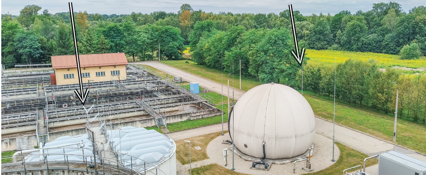
TEREN PRZEZNACZONY NA NOWE OKRĄGŁE OSADNIKI WTÓRNE
