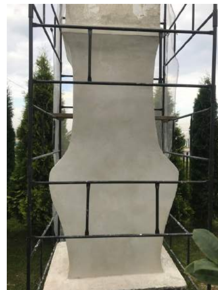
W trakcie uzupełniania tynku
