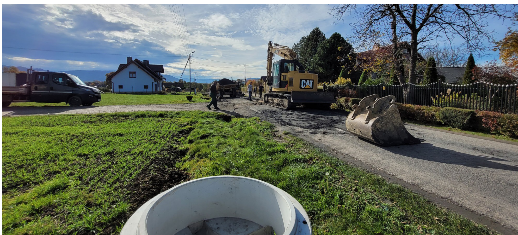
Ul. Świerkowa - prace ziemne
